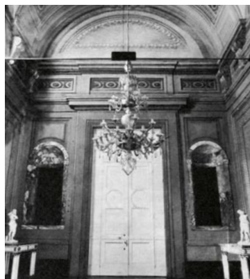
Fig. 5. Palazzo Pitti, vestibolo della Galleria Palatina: le due finestre a nicchia di marmi misti, poi murate.
